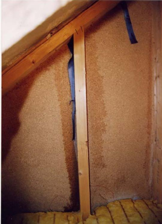
Giebeldreieck im Spitzboden, außen gedämmt mit 40 mm Polystyrolschaum. Die aus dem Hohlraum der Lattung an den Anschluss-Stellen der Mineralwolle aufsteigende Warmluft hinterlässt starke Feuchtespuren - die Luftdichtungsebene war perfekt durchgebildet!
