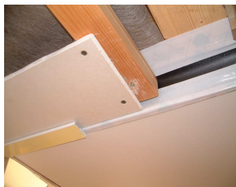
5) Lattung anpassen, verschrauben und mit Gips verkleiden.
