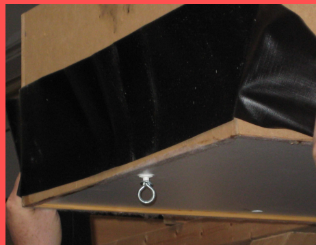
1) Manschette an Futterkasten-eckpunkten ansetzen,
