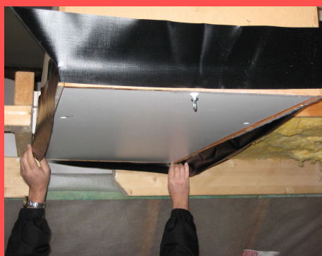
2) Manschette stramm über den Futterkasten ziehen,
