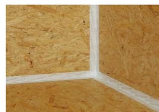
Ecke mit SIGA-Corvum 30/30 passgenau und faltenfrei luftdicht verklebt
