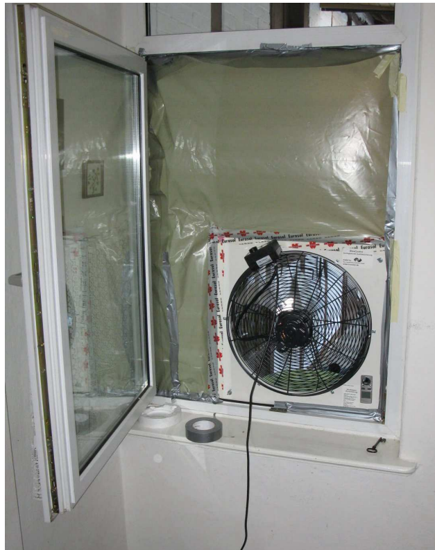
Das BlowControl-Gerät in ein Fenster eingebaut
