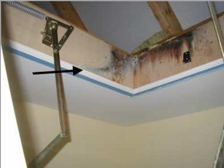
Man sieht an der Ausbildung des Schimmelschadens sehr gut, wie die warme Innenraumluft durch eine undichte Dichtung der Bodenklappe zu einem Spitzboden geströmt ist (Pfeil). Dieser Feuchteschaden ist eingetreten, obwohl die Blower-Door-Messung den Wert 1,0 [1/h] ergeben hat!
